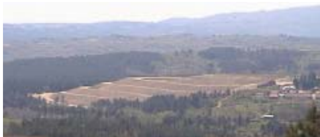
Reabilitação da Escombreira da Mina de Jales
